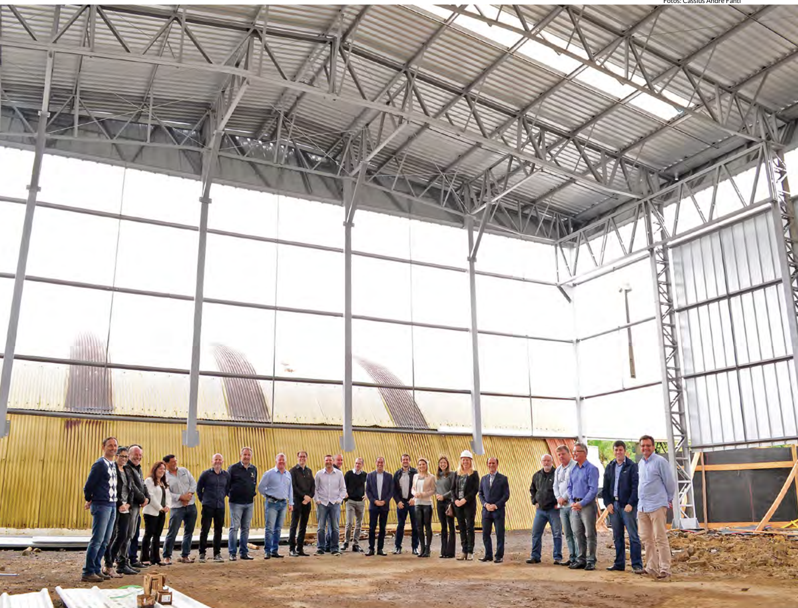
Visita às obras do novo pavilhão da Fenachamp
