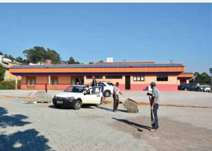
Calçamento da sede da CIC
